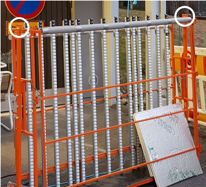
Nostokori kiinnitetään parveketelineeltä tuleviin nostoköysiin.
